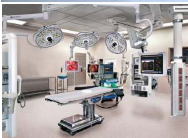
Transformacja Hybrydowej Sali Operacyjnej w Salę typowo chirurgiczną (Ramię C i stół specjalistyczny w pozycji nie utrudniającej pracę)
